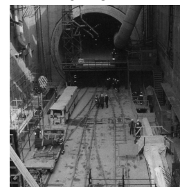
Строительство Лефортовского тоннеля
