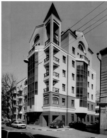
Административное здание, ул.Трубная, д.25
