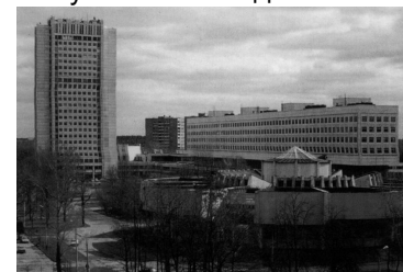
Здание МГСУ на Ярославском ш., д.26
